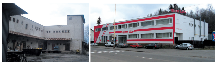
Pohľad na budovy firmy Glass LPS pred rekonštrukciou (vľavo) a po nej.
