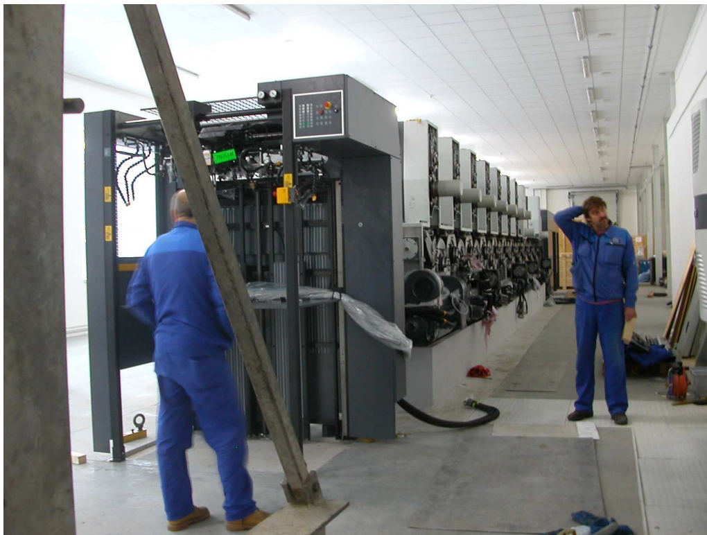
4/ Elektroinštalačné práce na 7-farebnom ofsetovom stroji s 2 lakovacími jednotkami manroland R-707 LTTLV
